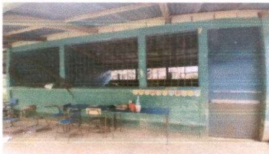
FOTO 17: PINTURA EN MUROS EXTERIORES E INTERIORES
