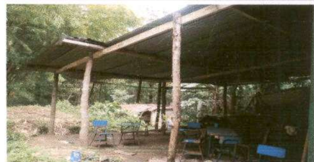
FOTO 18: MODULO 2 BODEGA, CUBIERTA DE LAMINA
