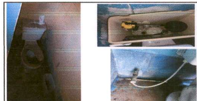
Foto 6: Sustitución de accesorios inodoro (contra llave, tubo de abasto y tanque)
