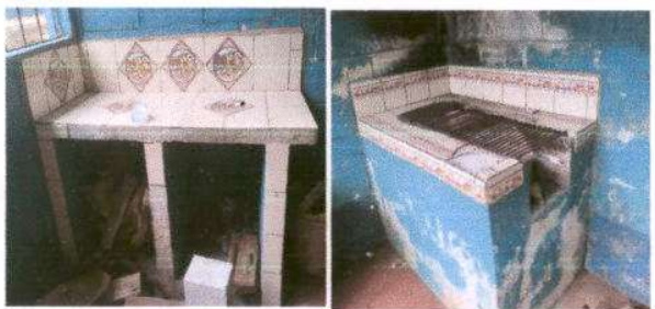
FOTO 9: MODULO 2 REPARACIÓN DE COCINA Reparación de azulejo en muebles de cocina
