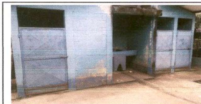
Foto 5: SERVICIOS SANITARIOS Y SUS ACCESORIOS Mantenimiento a estructura (lijado, cambio de tubo, cepillado, sujeciones, aplicación de pintura) a puertas servicios sanitarios
