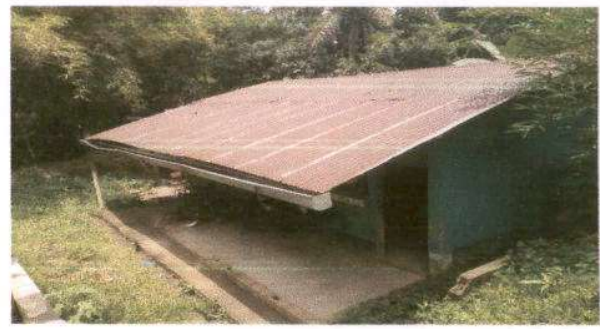
FOTO 14: CUBIERTA DE LAMINA
