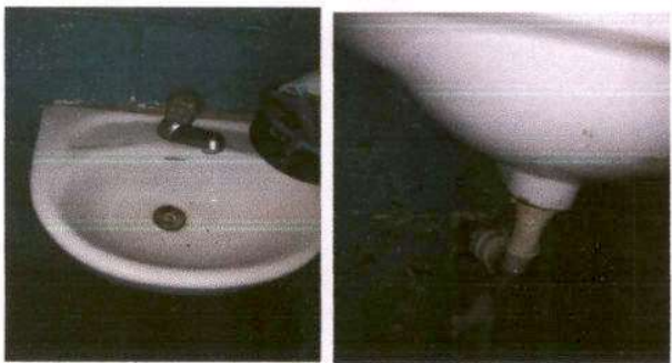
Foto 7: Sustitución de lavamanos
