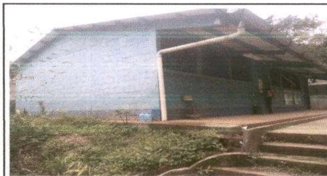
Foto 3: PINTURA EN MUROS EXTERIORES E INTERIORES MODULO 1
