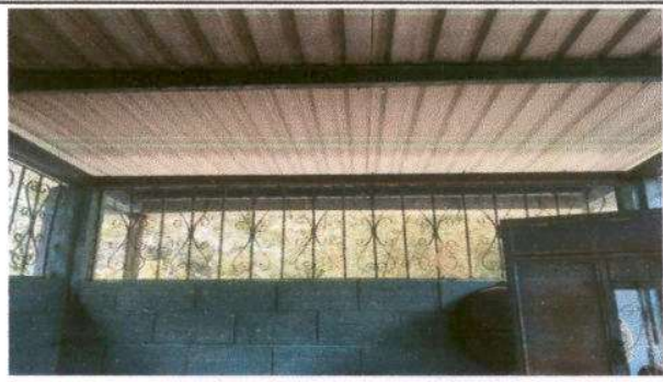
Foto 10: MODULO 2 COCINA MANTENIMIENTO DE ESTRUCTURA DE SOPORTE DE METAL
