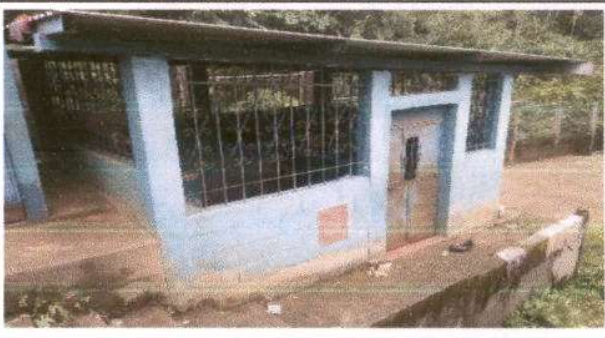
Foto 12 : COCINA PUERTAS DE METAL Y MANTENIMIENTO A VENTANAS, BALCONES DE METAL
