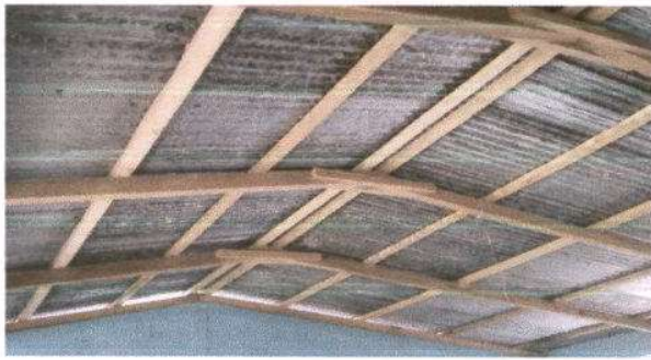
FOTO 13 AULA 3 MODULO 2 ESTRUCTURA DE TECHO SUSTITUCIÓN DE ESTRUCTURA DE SOPORTE DE MADERA POR METAL
